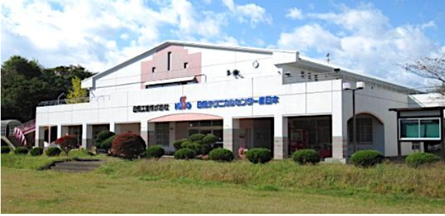
【Nisso Technical Center Higashi-Nihon】
